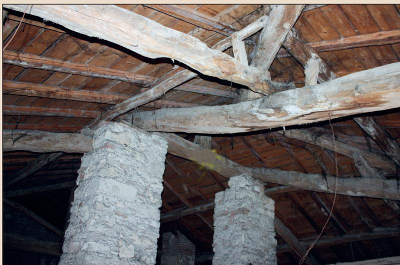
I principali elementi rilevati sono **l'insufficienza statica della copertura lignea della sacrestia e lo stato precario delle connessioni tra gli elementi lignei. Il ripristino della situazione ottimale delle connessioni è necessario per il sicuro consolidamento delle strutture sia dal punto di vista statico sia dal punto di vista sismico.**
